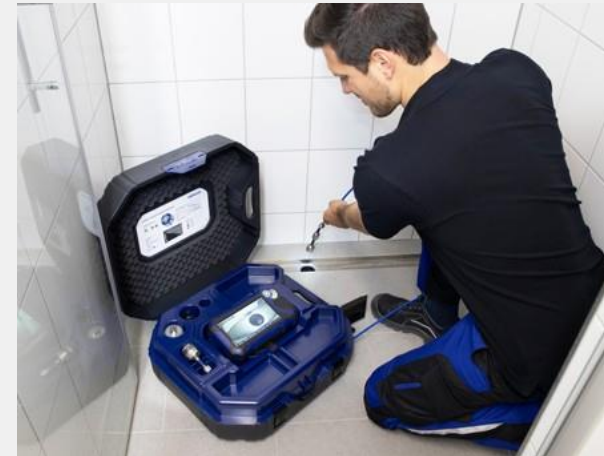
Vesitiivis kamerapää mahdollistaa mm. viemäreiden tarkastamisen.
